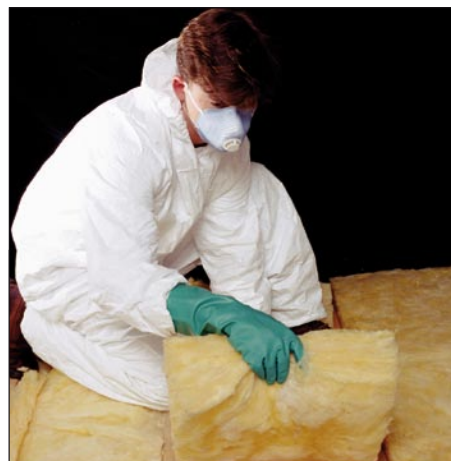
Glaswol voor isolatie wordt gemaakt uit zand en gerecycled glas. Ook steenwol bestaat voornamelijk uit siliciumdioxide, namelijk uit de gesteenten diabaas of basalt.
